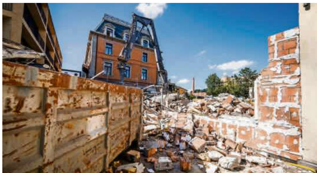
Plötzlich eine Lücke: Gestern wurden die drei Häuser an der Bahnstrasse 1 und 3 abgerissen
